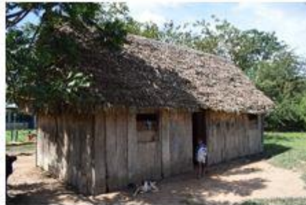
Vivienda colectiva en comunidad Los Tubos
