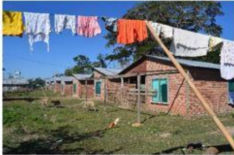
Emplazamiento tipo campamento de clima frío, expuestas a fuerte asoleamiento.
