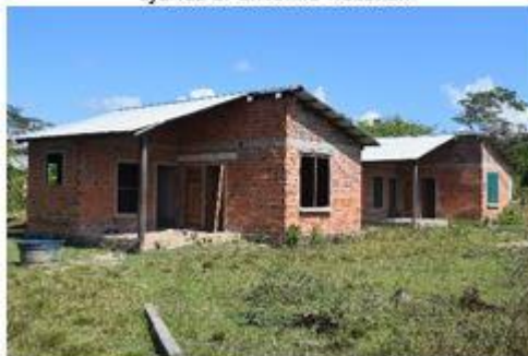
Amplias ventanas con aleros cortos elevan la temperatura interior.
