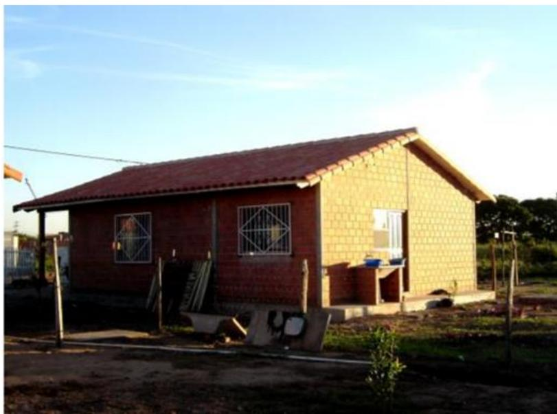
Figura 4. Imágenes de viviendas sociales instaladas en Santa Cruz que muestran la materialidad de muros, ventanas, carpintería, cubierta y vidrio. Fotografías: Roca (2018) y Hurtado (2011).
