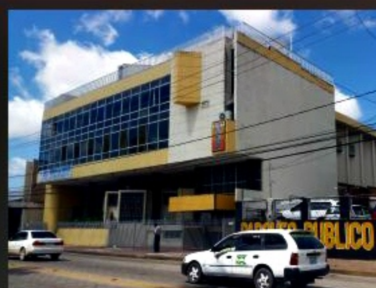
FIG 4: Vista general - cine "El Arenal" FUENTE: Foto del autor, 10-2016.
