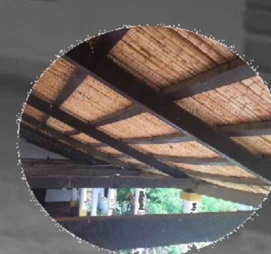
Fig. 04 Estructura de techo
