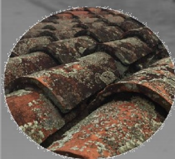
Fig. 01 Cubierta de teja cerámica.
