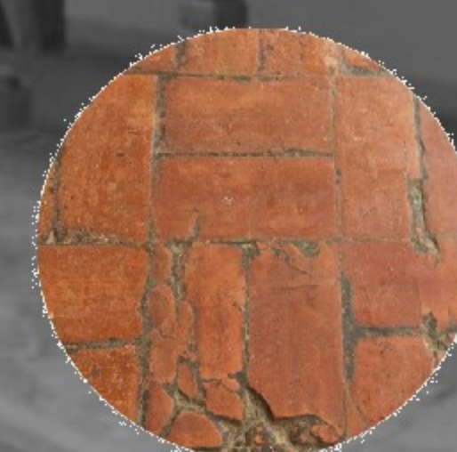
Fig. 03 Piso de ladrillo cerámico.
