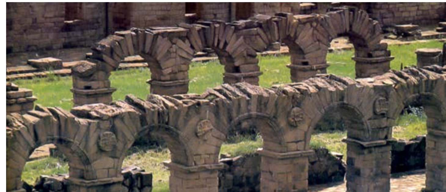
En Trinidad, Paraguay, las galerías de las casas se hicieron con arquerías gracias al uso de cales. / Foto: Colección CEDODAL.
