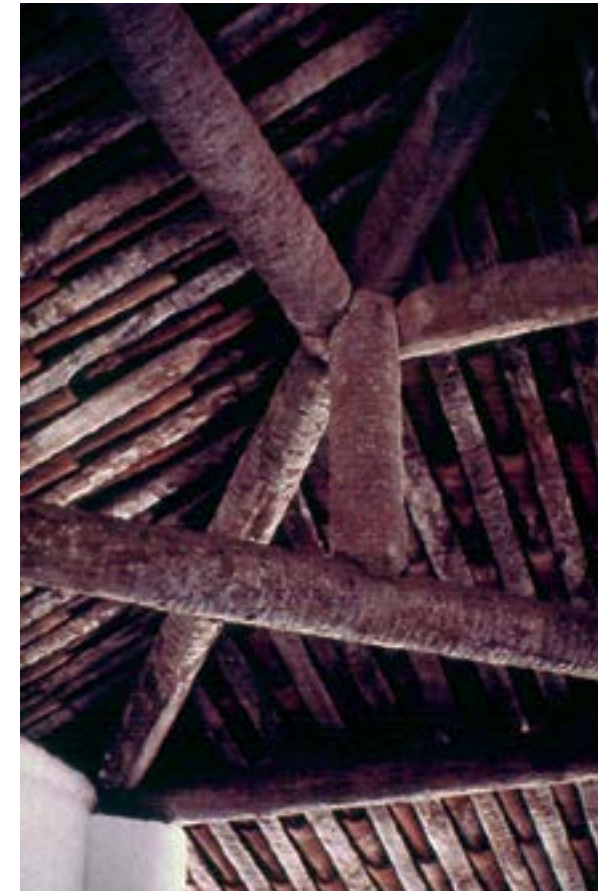
Los troncos de palma usados en la estructura de un techo. / Foto: R. Gutiérrez. Colección CEDODAL
