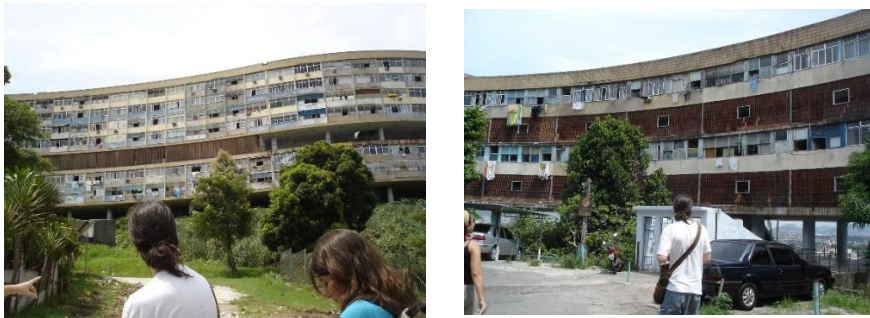
Figura 14: Izq. Fachada Este - Der. Fachada Oeste
