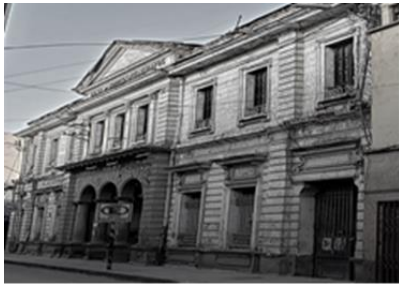
Figura 01: Edificio de Telégrafos y Correos Fuente: Foto Ramos, 2020
