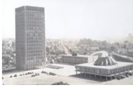
Fig. 07: Edificio residencial Fuente: Mealla, 1970
