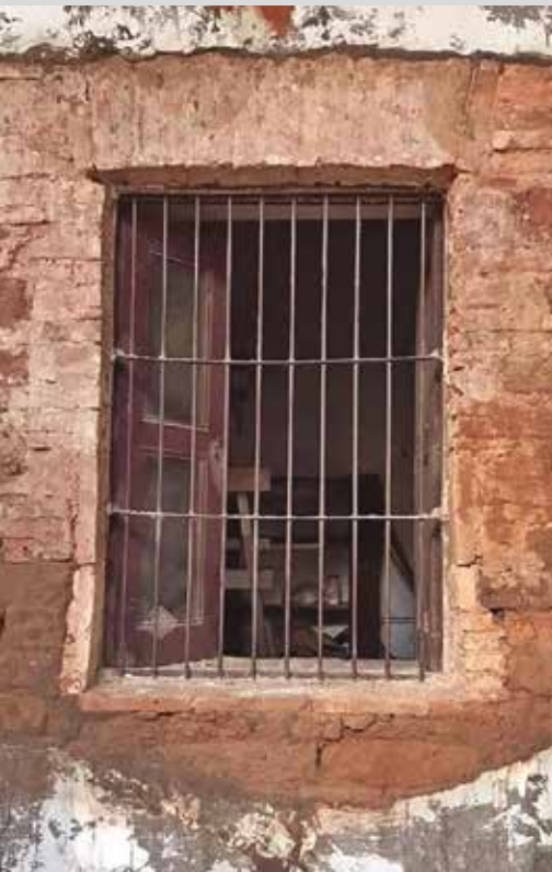
Lámina No. L-66.- Proceso de restauración de ventana en la sacristía: A.- Reposición de revoque de barro. B.- Recuperación de dintel de ladrillo. C.- Enlucido a la cal. D.- Reposición de color en carpintería a partir de la información de calas estratigráficas.
