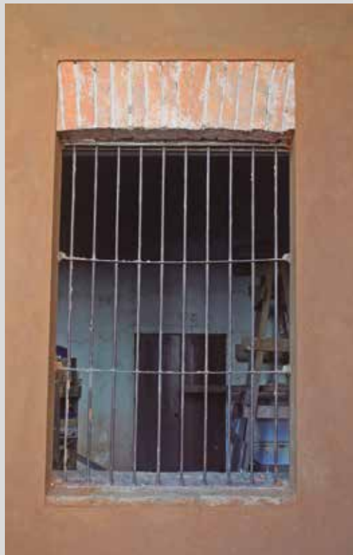
Lámina No. L-66.- Proceso de restauración de ventana en la sacristía: A.- Reposición de revoque de barro. B.- Recuperación de dintel de ladrillo. C.- Enlucido a la cal. D.- Reposición de color en carpintería a partir de la información de calas estratigráficas.
