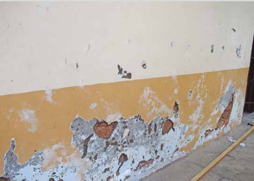
Lámina No. L-49. Vista de revoque negro en muro de galería interior.
