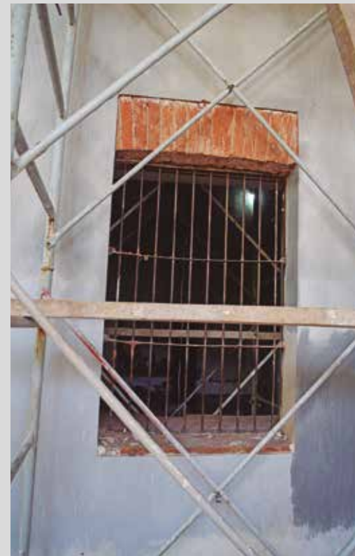
Lámina No. L-66.- Proceso de restauración de ventana en la sacristía: A.- Reposición de revoque de barro. B.- Recuperación de dintel de ladrillo. C.- Enlucido a la cal. D.- Reposición de color en carpintería a partir de la información de calas estratigráficas.
