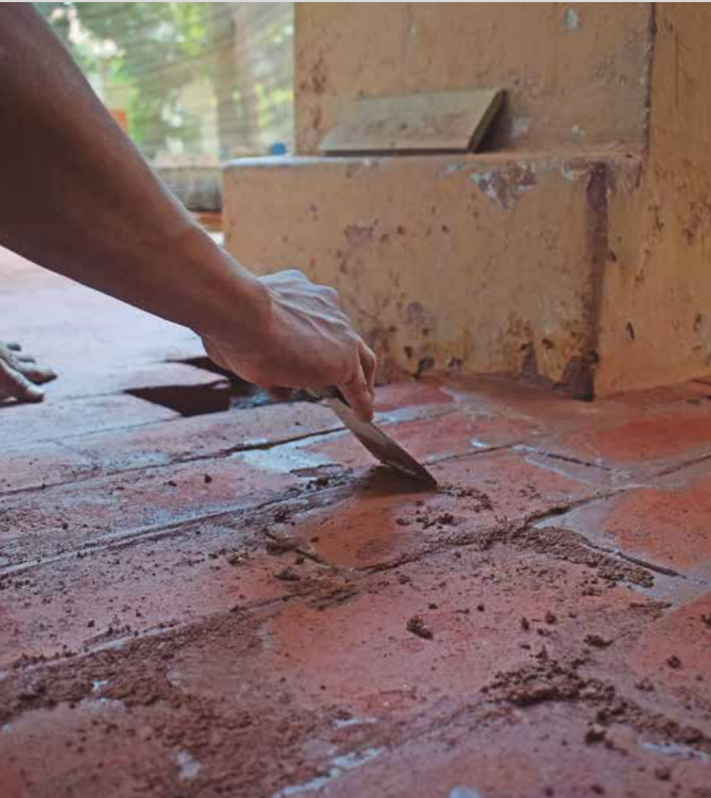
Lámina No. L-62.- Reposición de piso de ladrillo artesanal en la galería interior.
