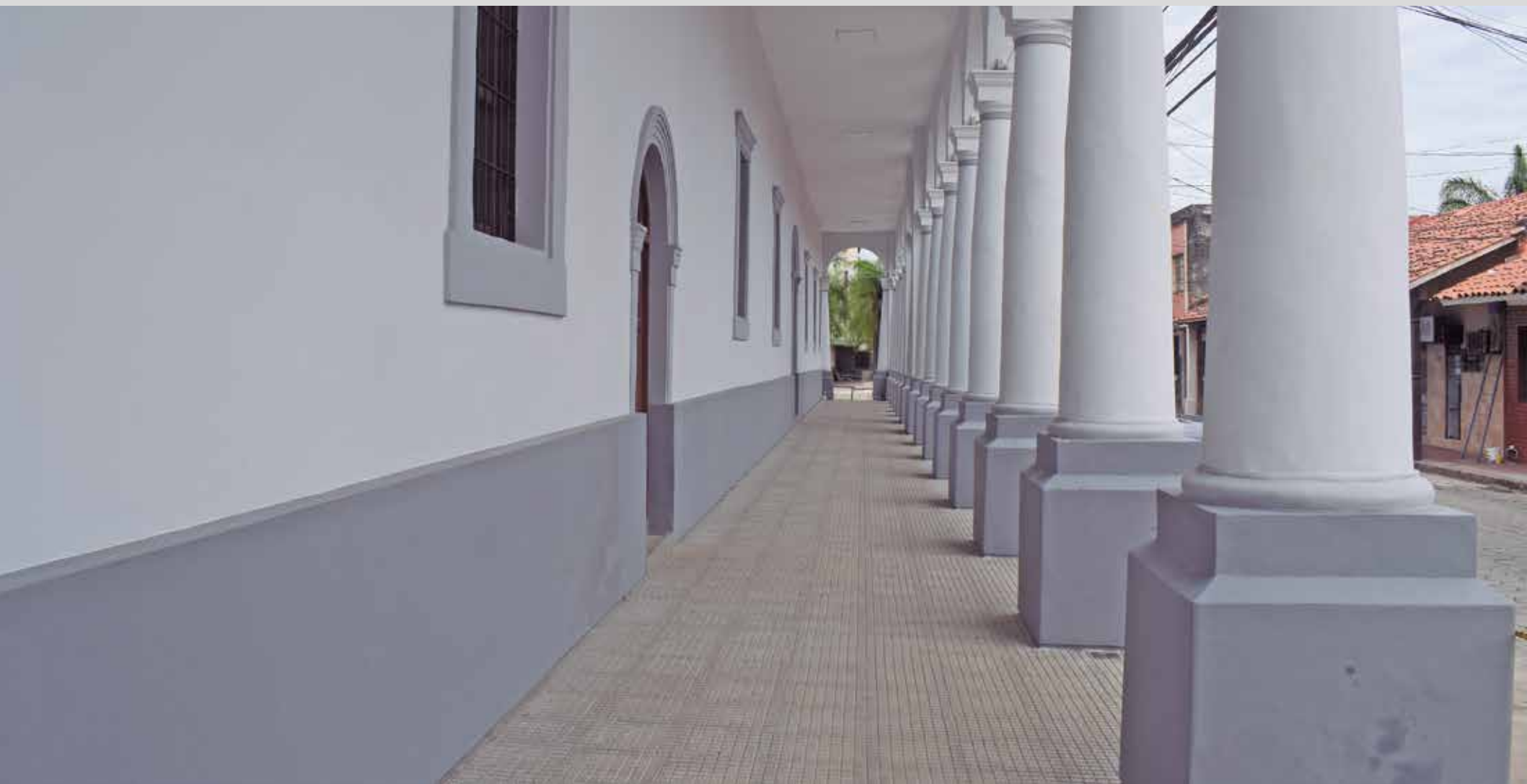
Lámina No. L-32.- Vista de la galería conformada por la arcada norte
