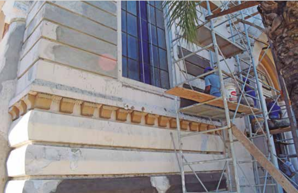
Lámina No. L-51. Reposición de revoque de cal y arena sobre muros de ladrillo.
