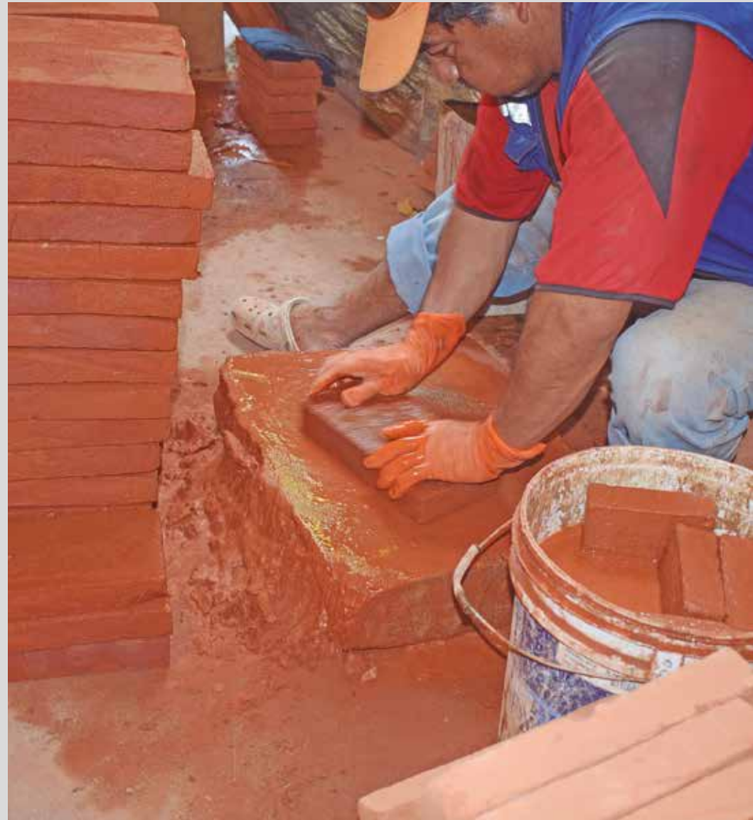
Lámina No. L-62.- Reposición de piso de ladrillo artesanal en la galería interior.
