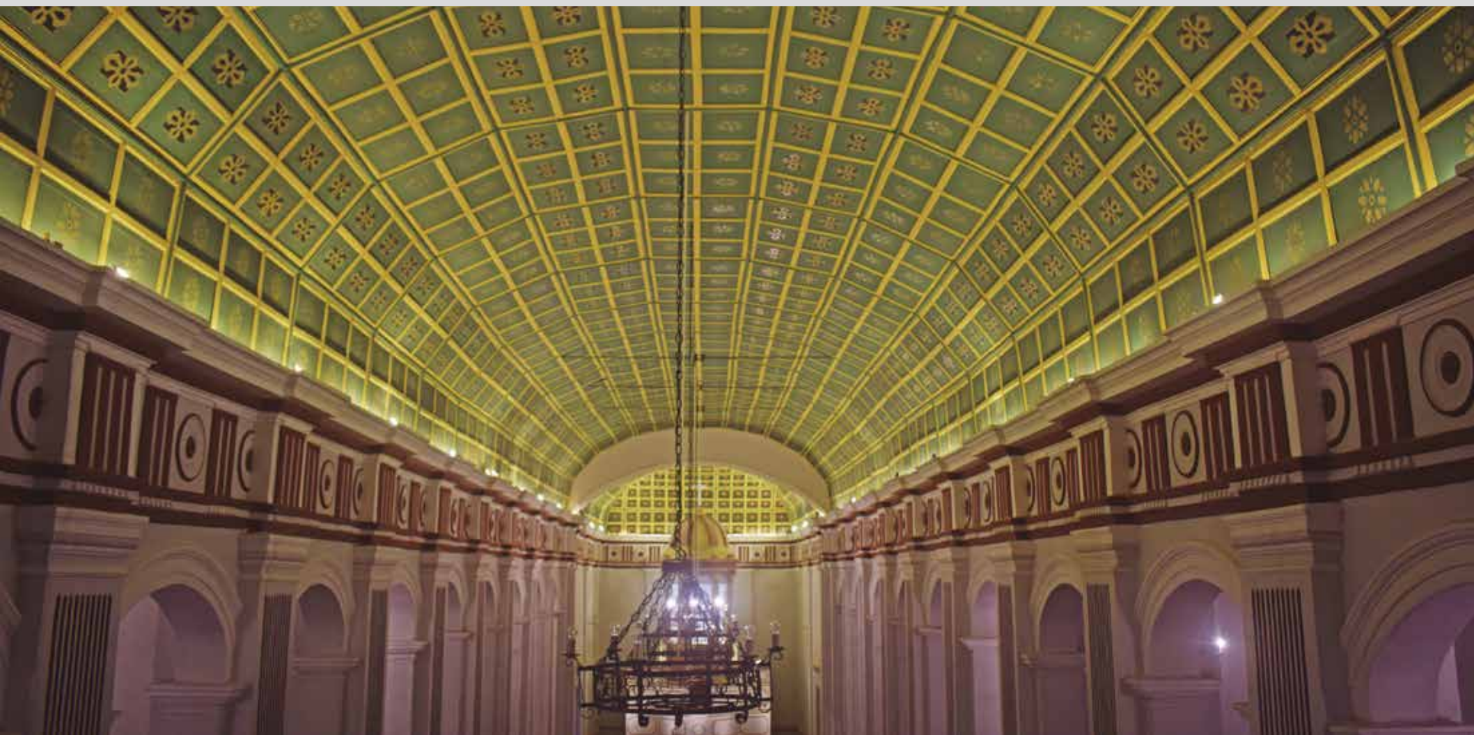
Lámina No. L-65.- Artesonado de nave central conformando la bóveda falsa de madera
