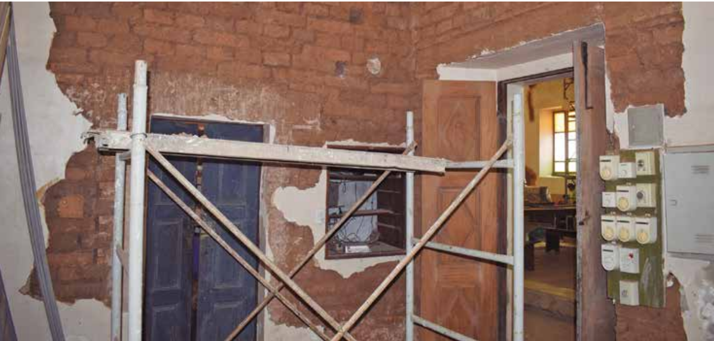
Lámina No. L-12: Vista del interior de la Sacristía, fase construida por el padre Lara con muros de adobe, los cuales permanecieron cubiertos por revoque durante 120 años hasta ver la luz en la intervención del año 2019.
