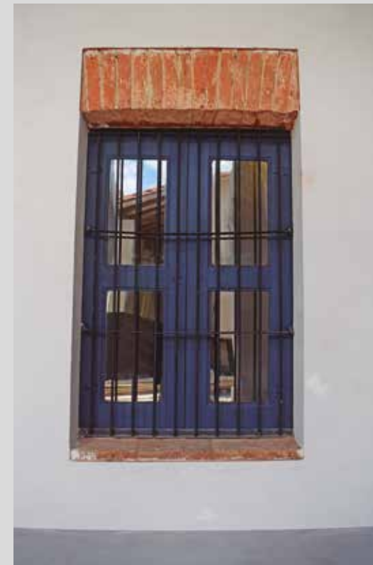
Lámina No. L-66.- Proceso de restauración de ventana en la sacristía: A.- Reposición de revoque de barro. B.- Recuperación de dintel de ladrillo. C.- Enlucido a la cal. D.- Reposición de color en carpintería a partir de la información de calas estratigráficas.
