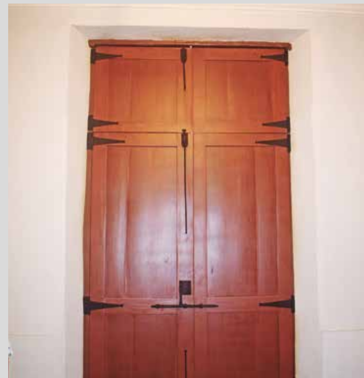
Lámina No. L-67.- Restauración de puertas de madera y reposición de color de acuerdo a información de las calas estratigráficas
