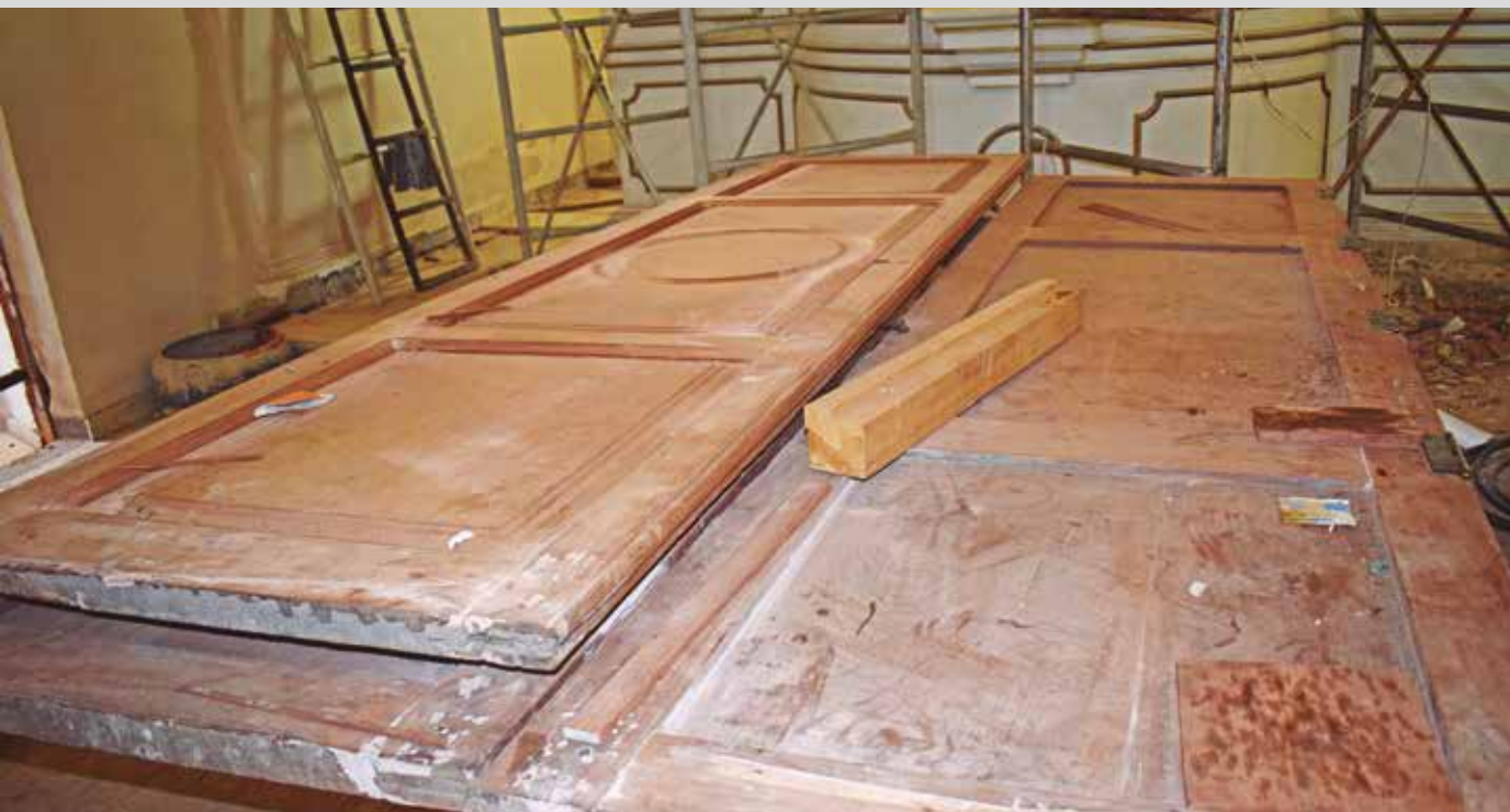
Lámina No. L-67.- Restauración de puertas de madera y reposición de color de acuerdo a información de las calas estratigráficas
