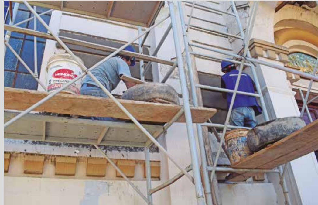
Lámina No. L-51. Reposición de revoque de cal y arena sobre muros de ladrillo.
