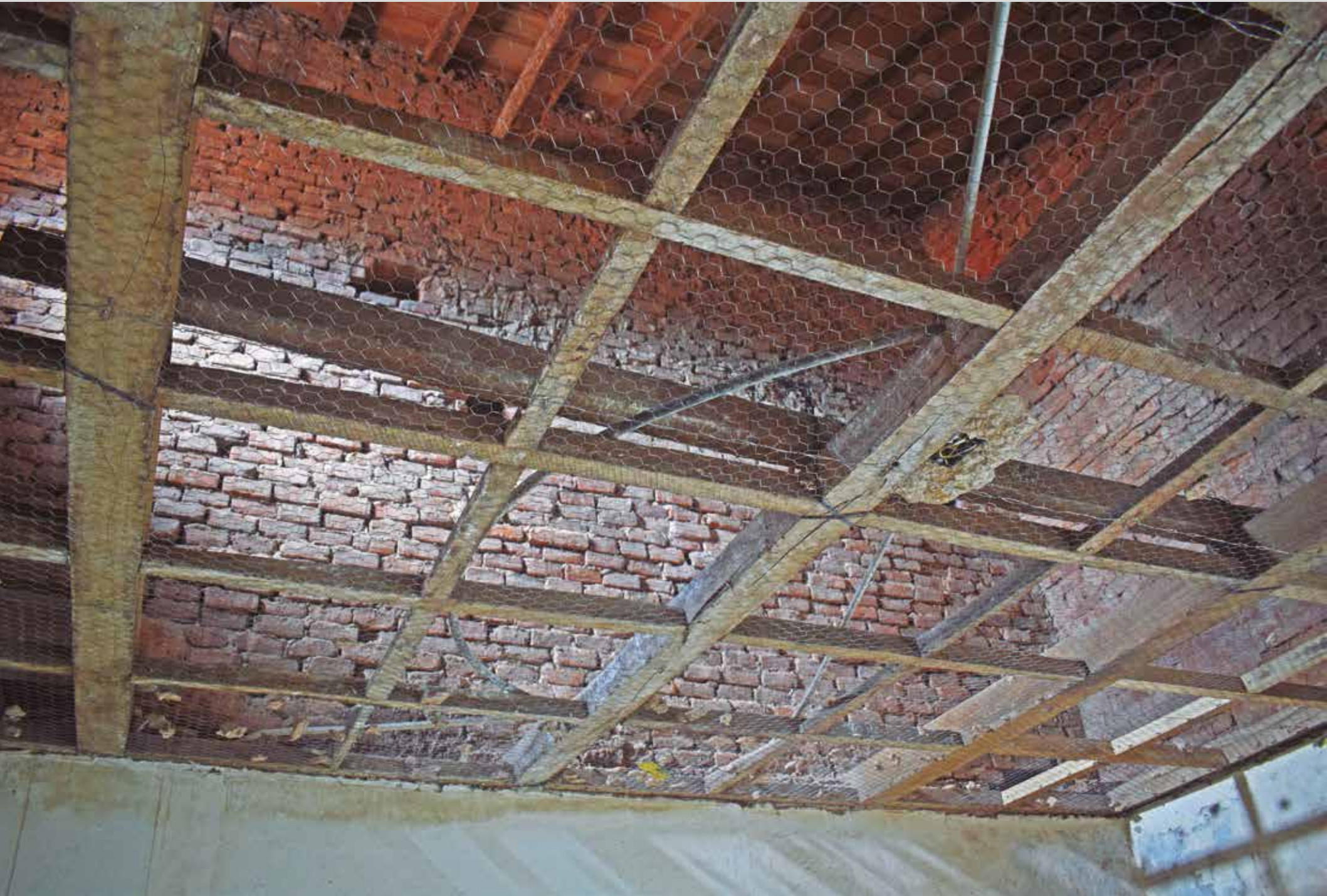
Antiguo entramado de cielo falso.
