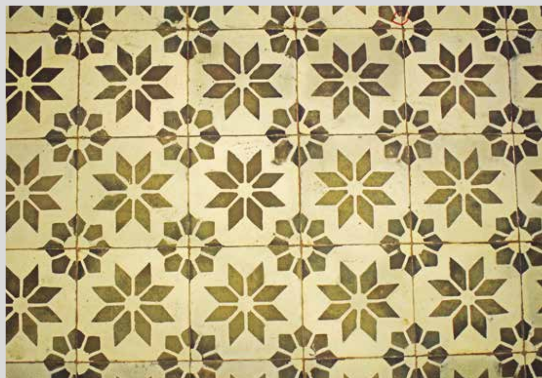
Lámina No. L-64.- Pisos de mosaico con plantillas de diseño creadas para la restauración.
